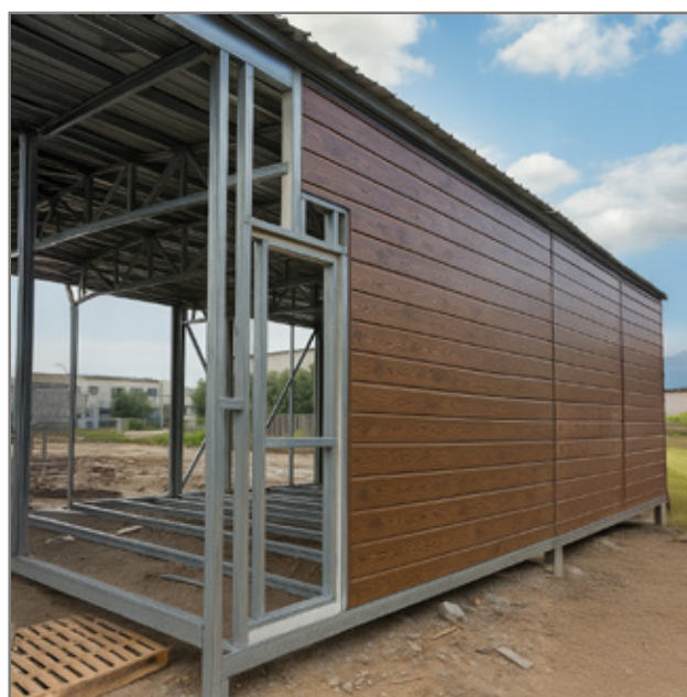
SOBRE ESTRUCTURAS METÁLICAS AUTOPORTANTES
