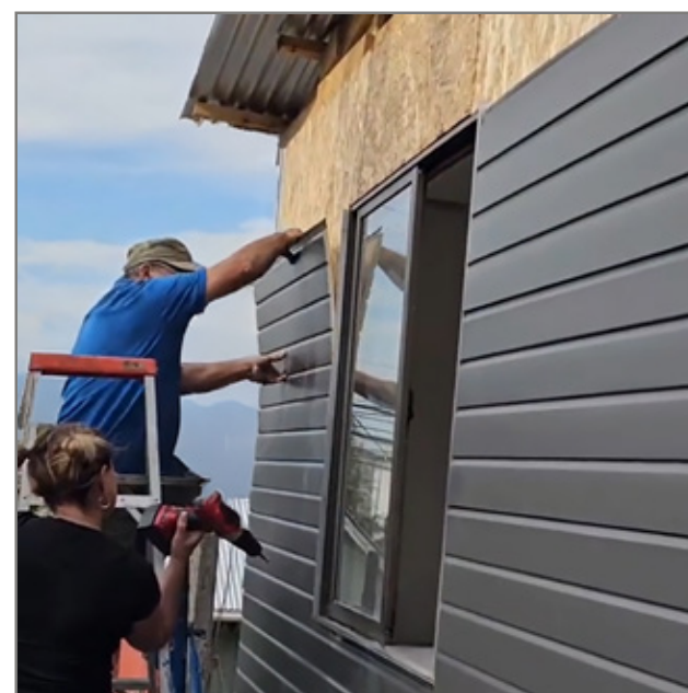
SOBRE ESTRUCTURA DE MADERA
